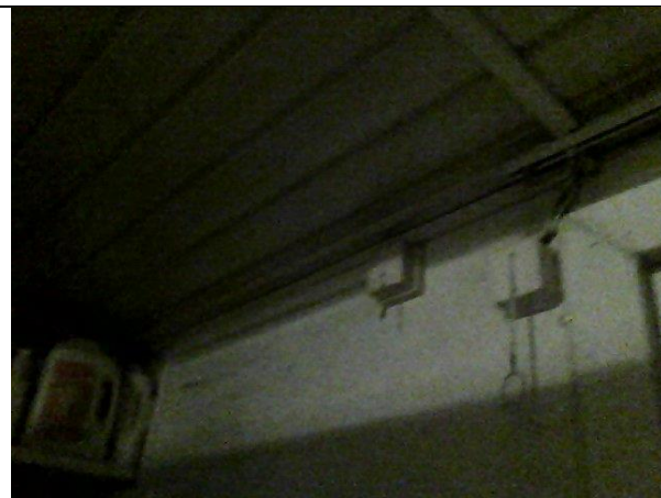
Koude lek bij de aansluiting plafond / muur. Oplossing plafond losnemen, koude lek dichten en plafond herstellen.
